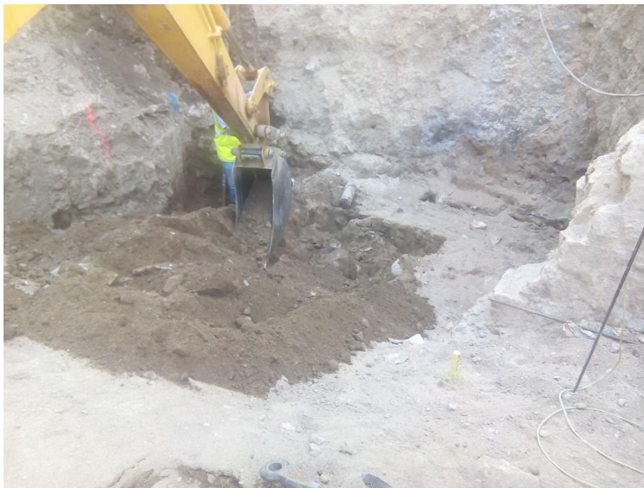
Vista del rebaix per realitzar la sabata al nord de la contraescarpa.
