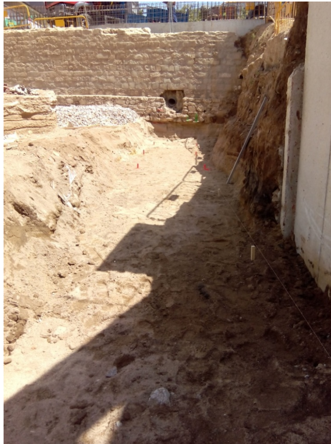
Vista del rebaix de la sabata situada al sud del jaciment.
