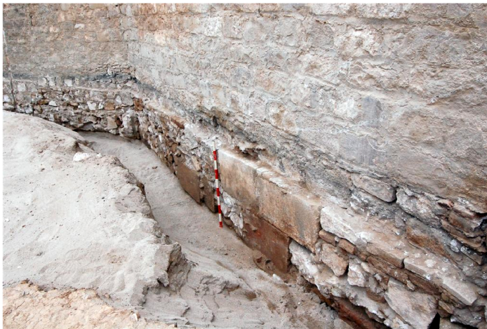
Foto 32 i 33. A l'esquerra detall dels carreus reaprofitats en la construcció del fonament UE 256. A la dreta, el cim de la contraescarpa, on es veuen les empremtes dels maons en sardinell de la coronació.
