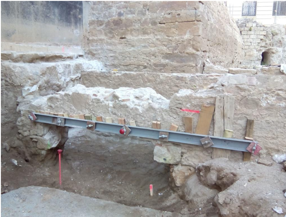
Vista del desmuntatge del mur del Rec Comtal UE 190.
