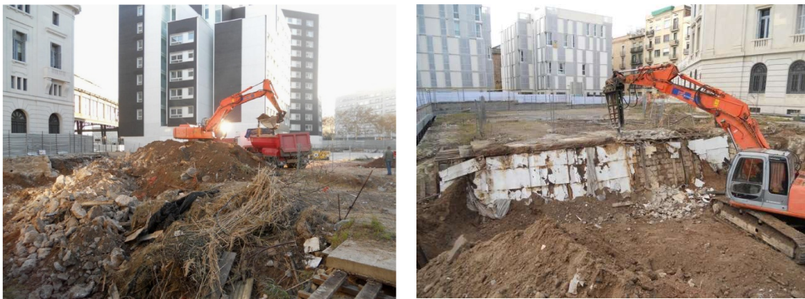
Foto 4 i 5. A l'esquerra vista del rebaix de solar. A la dreta eliminació del cobriment de fusta i formigó del flanc del baluard.
