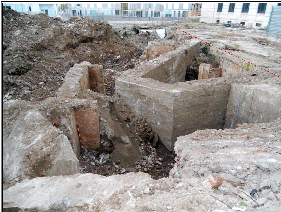
Foto 6. Les restes dels dos edificis d'època contemporània des de la banda NE. Es pot veure la superposició de la planta triangular de formigó encofrat sobre la rectangular del segon edifici. La línia vermella afegida marca el traçat de la muralla i baluard.
