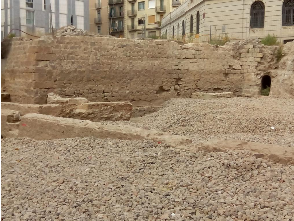
Imatge del procés de col·locació de la primera capa de graves.
