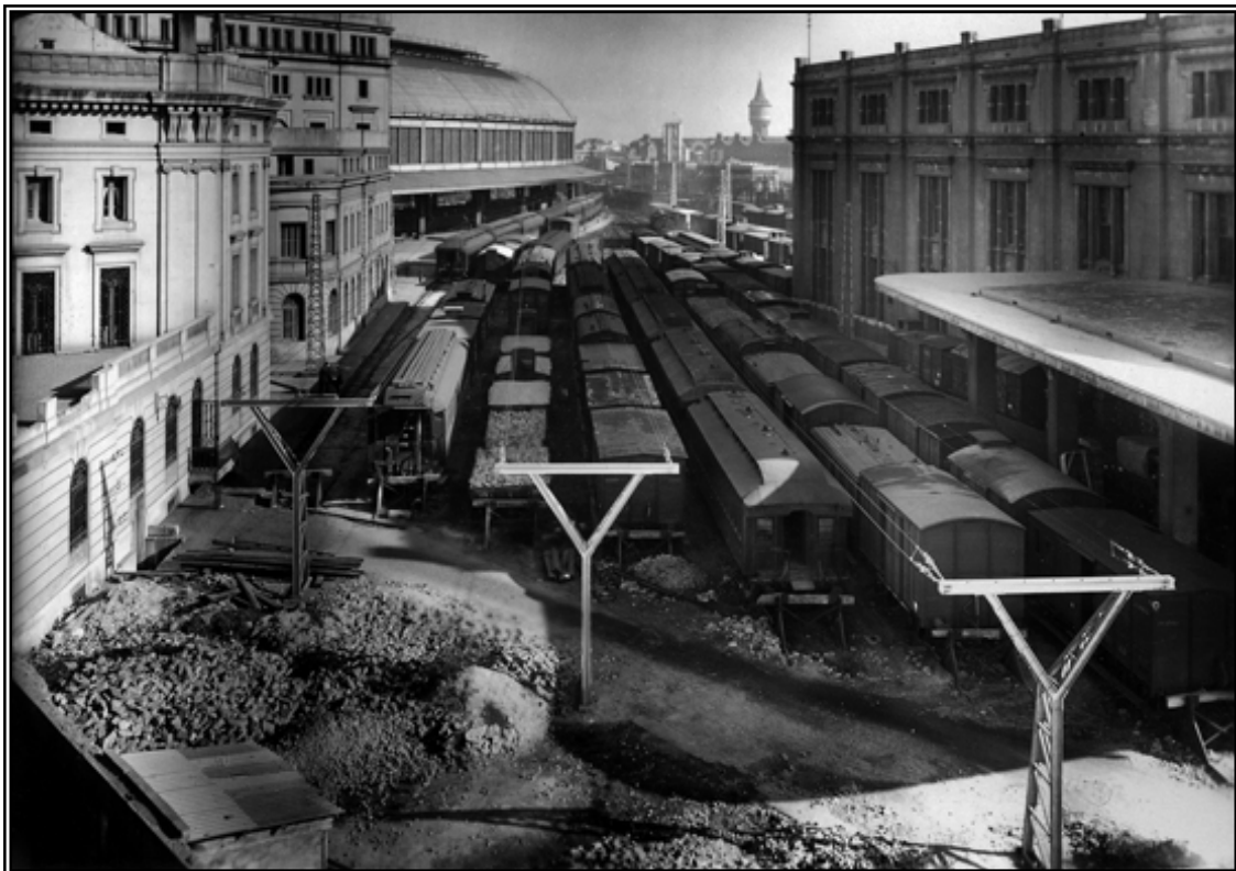
Vista del ramal de vies l'any 1949. Al fons es pot veure la coberta de l'estació de França i a la esquerra de la foto, l'actual edifici del Ministeri de Foment. (Font: Servicio Electrico MFVG-FFE)
