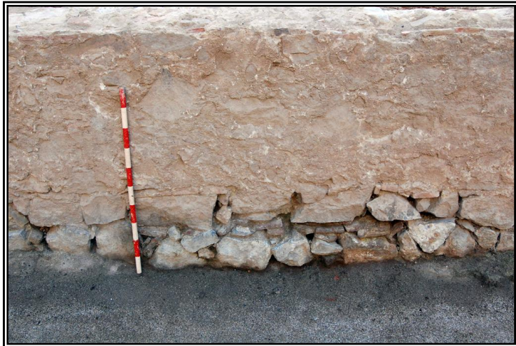
Foto 20. Detall del mur UE 190.
