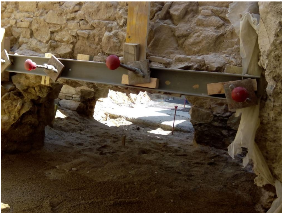
Imatge on es veuen els dos murs del Rec Comtal desmuntats parcialment.
